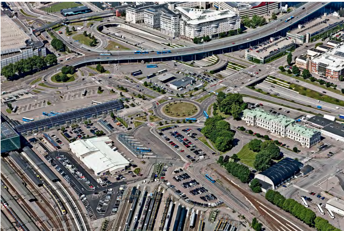
Figur 12.1:1 Resterande parkmiljö kring före detta Bergslagsbanans station. (Flygbild Stadsbyggnadskontoret)
