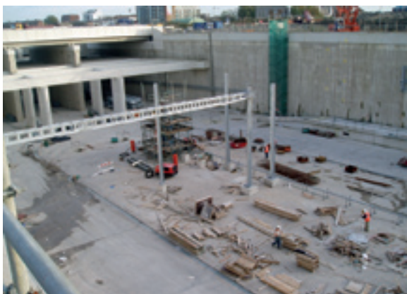
Betongstation Stratford Box som byggs i östra London utförs med permanenta slitsmurar. Denna station är öppen mot himlen och inte överbyggd.
