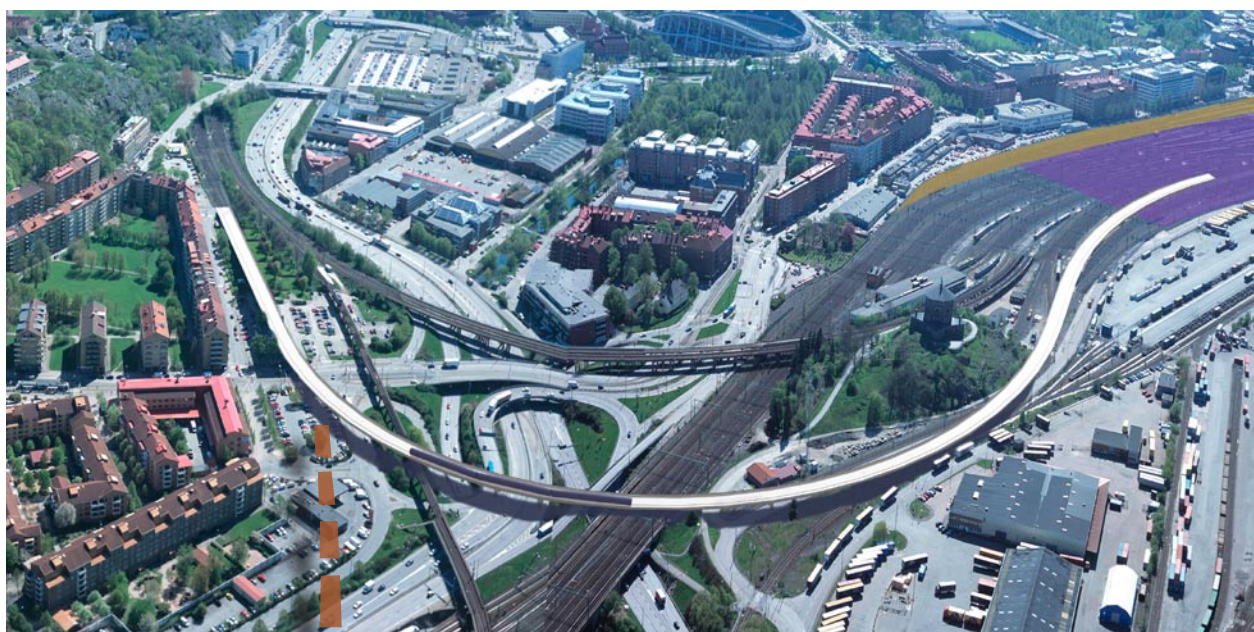
Järnvägsbro norr om Skansen Lejonet - Gullberget (Förstärkningsalternativet). Vy från nordost.
