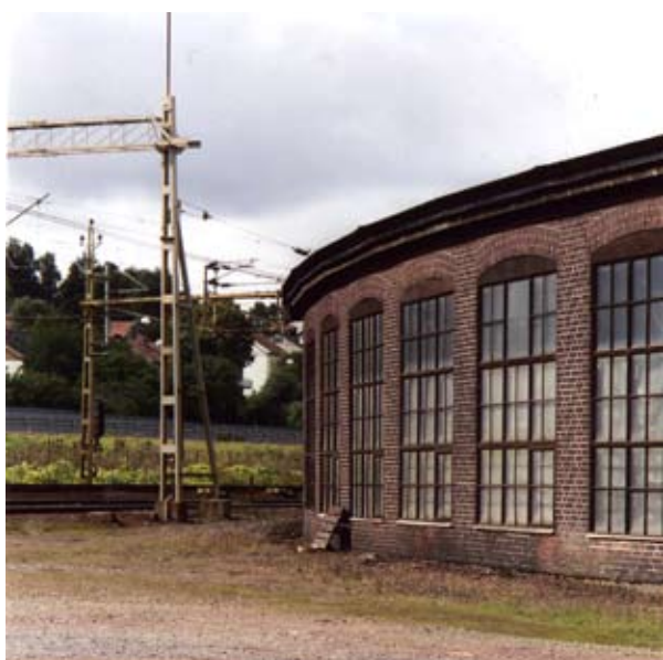
Sävenäs lokstation, södra lokstallet.
