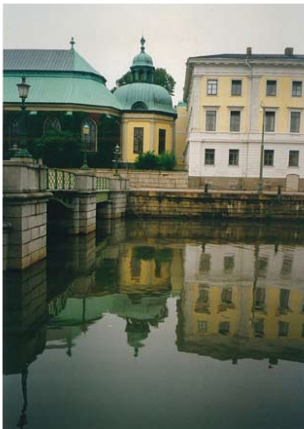
Tyska kyrkan, Rådhuset, Tyska bron. Om tunneln byggs i Stora Hamnkanalen påverkas fornlämningar, kanalkanter, broar och byggnader. Kompletterande utredningar krävs för att klarlägga konsekvenserna.
