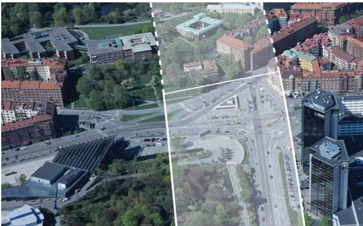
Korsvägen och Johannebergs landeri från öster. Alternativ Haga - Korsvägen påverkar nordöstra delen av landeriparken.
