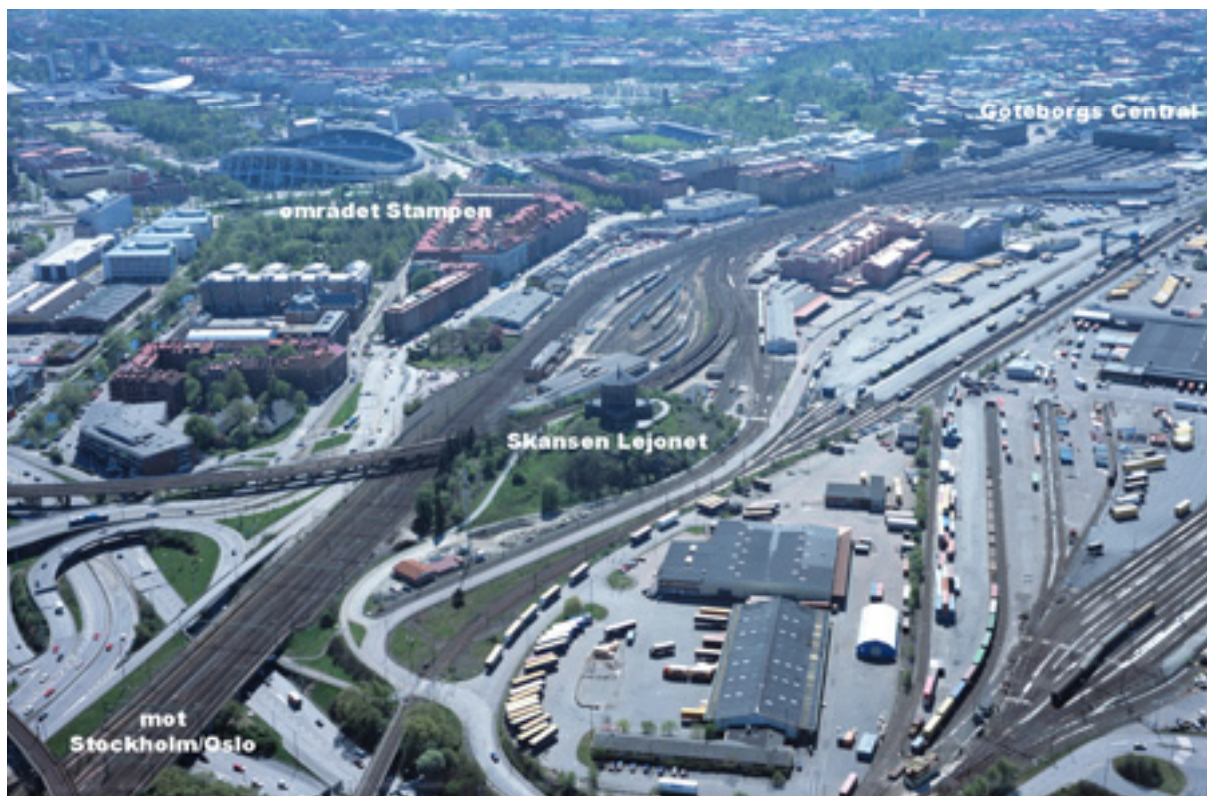
Figur 3. Flygfotografi över potentiellt utfyllt och förorenat område mellan Göteborgs Central, Kruthusgatan och Stampen (område 2 och 7). Här finns eller har funnits spårområde, lokstallar, fordonsverkstad med tvätt, bensinstationer och godsterminal. Vid Stampen har bl a funnits bilverkstäder, skrotanläggning, garveri och spinneri.
