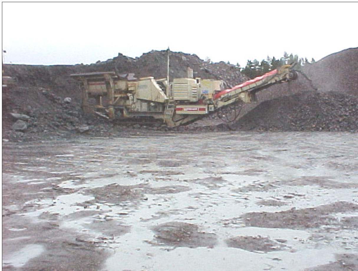
Figur 6.1. Mobil bergkross vid tunnelbygget i Näl, Trollhättan.
