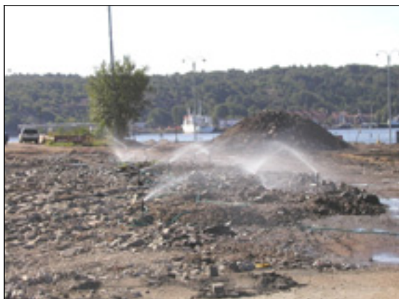
Figur 2. Exempel på behandling av förorenad jord. Jorden läggs ut och sprinklas med bakterier som påskyndar nedbrytningen av olja.
