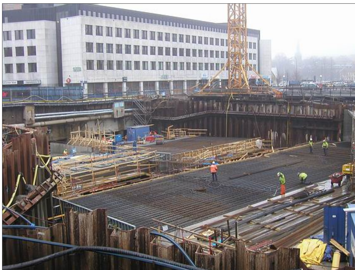
Figur 5.1. Tunnelbygge med hjälp av cut & cover-metoden vid Götatunneln, Göteborg.
