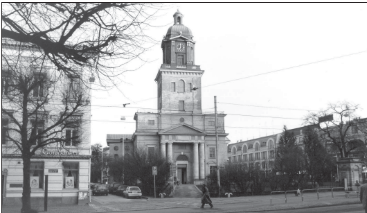
Bild 10. Domkyrkan återuppfördes efter branden 1802 av tegel och sandsten i Carl W Carlbergs ädla nyklassicism. Framför kyrkan anlades 1823 ett stenlagt torg, men 1860 omgavs kyrkan istället av planteringar och grusgångar med inhägnad av järn mot gatorna. Th vid staketet det lilla källhus för Kallebäcksledningen - också ritat av Carlberg - som förr stod vid kanten av Västra Hamnkanalen.
