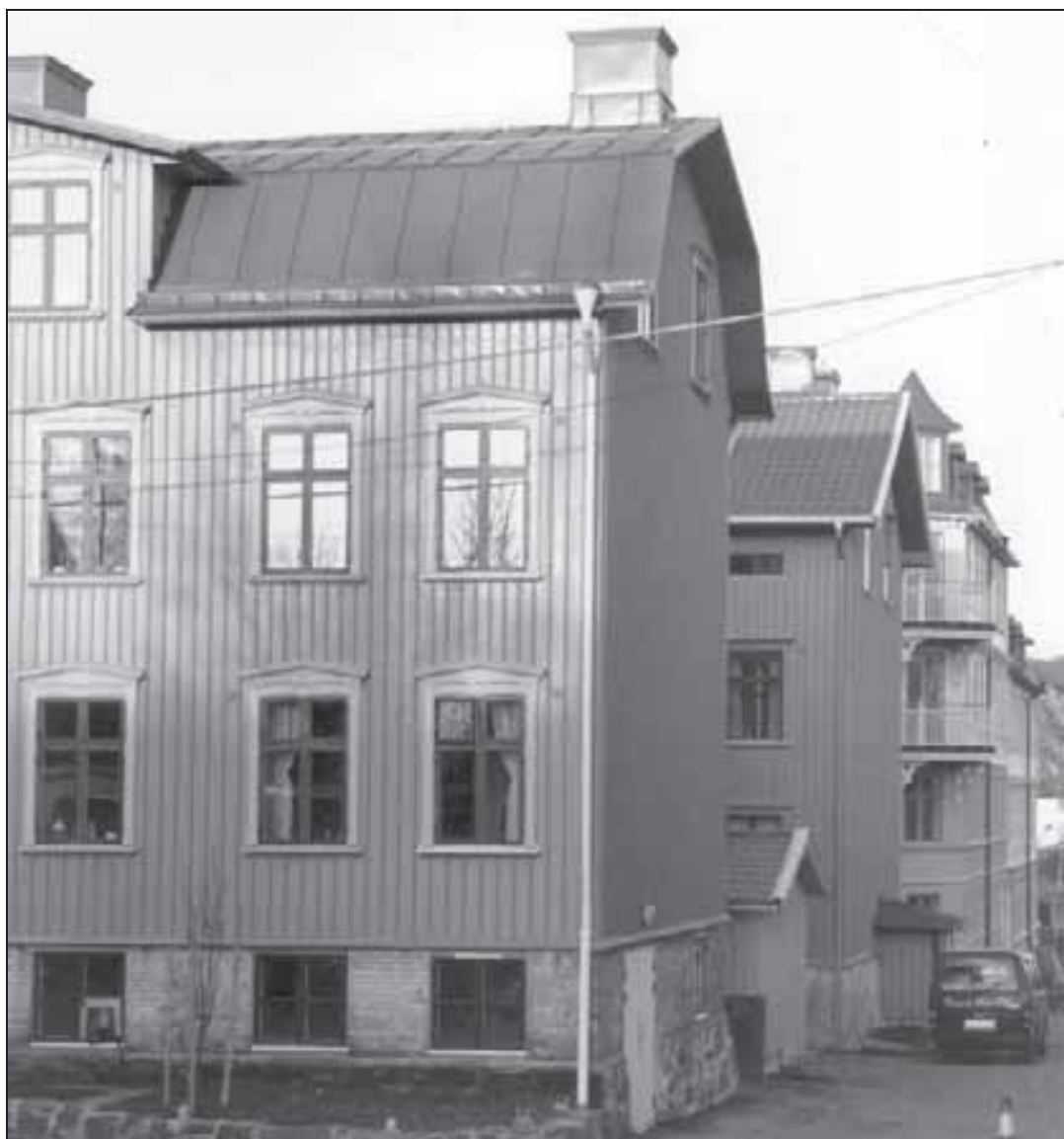
Bild 129. Verkmästaregatan mot norr.
