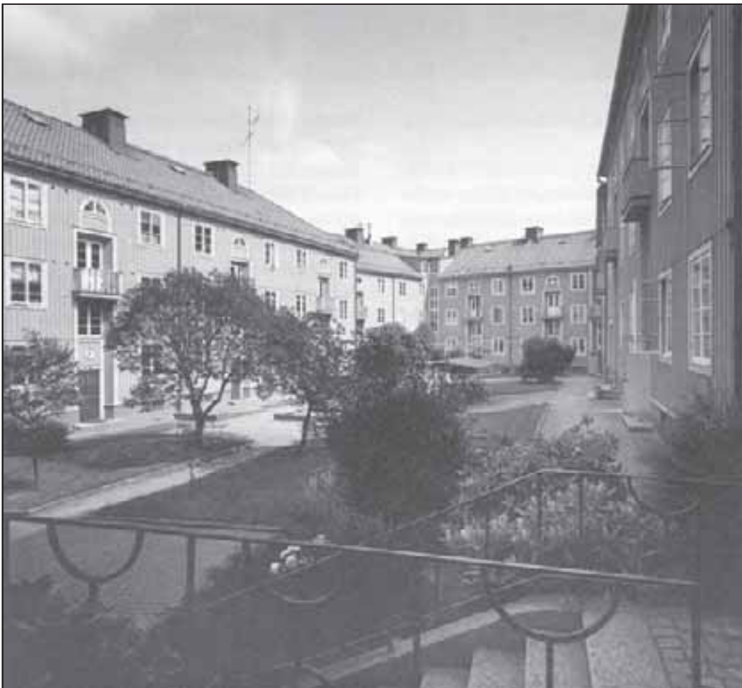
Bild 104, 105. Ett väsentligt inslag i 1910- och 20-talens stadsplanemönster är de s k storgårdskvarteren. Särskilt omsorgsfullt utformade bostadsmiljöer uppfördes av Broströmska Stiftelsen (kv Murgrönan, byggnader av rött tegel) och HSB (kv Svärds Liljan, landshövdingehus). Dessa enhetligt gestaltade kvarter utgör ypperliga prov på den göteborgska 20-talsklassicismens byggnadskonst.
