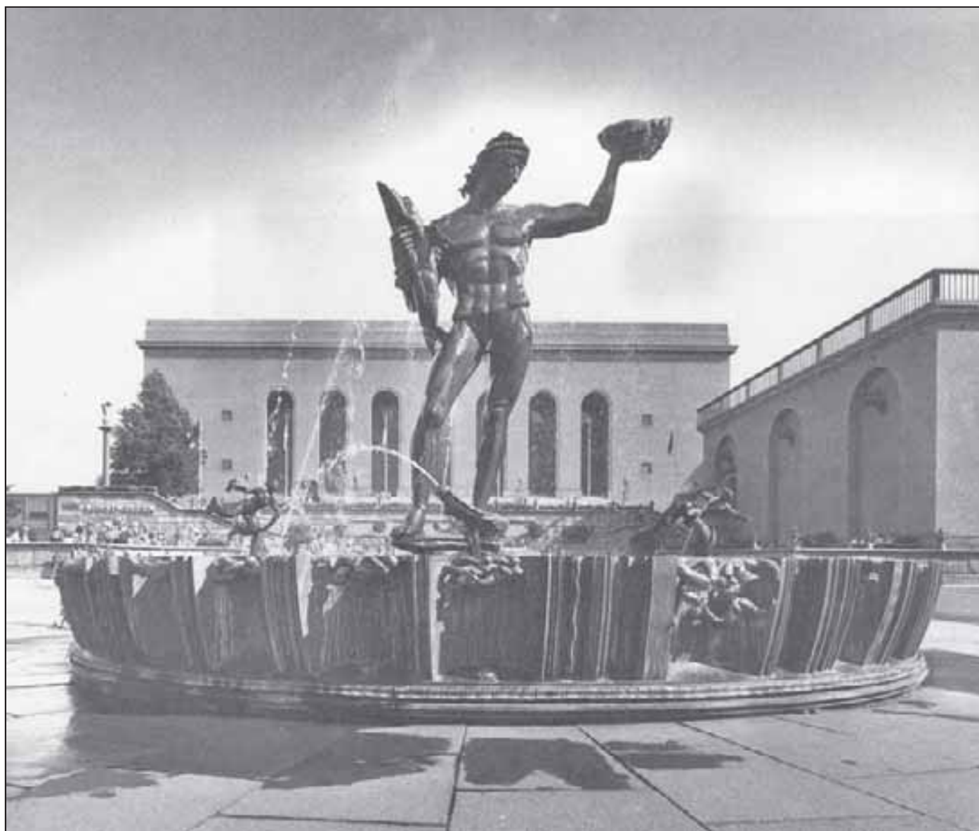
Bild 39. Frågan om en passande avslutning av Kungshuset mot Johannebergshöjden i söder var i början av 1900-talet ett hett tävlingsämne. Det blev slutligen arkitektgruppen ARES, formgivare av Jubileumsutställningens arkitektur, som i detta sammanhang fick det prestigefyllda uppdraget. Carl Milles skapade sedan den berömda Poseidonfontänen.
