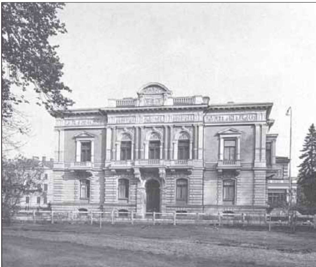
Bild 46. "Wernerska Villan" uppfördes 1885-86. För Handlanden Carl Wijk ritade Adrian Crispin Peterson detta privatpalats i italiensk renässans med fasader i cementputs och fogstruket rödgult frankfurtertegel. Byggnaden och dess båda förträdgårdar upptar ett av de s k parkkvarteren. Jfr bild 48.
