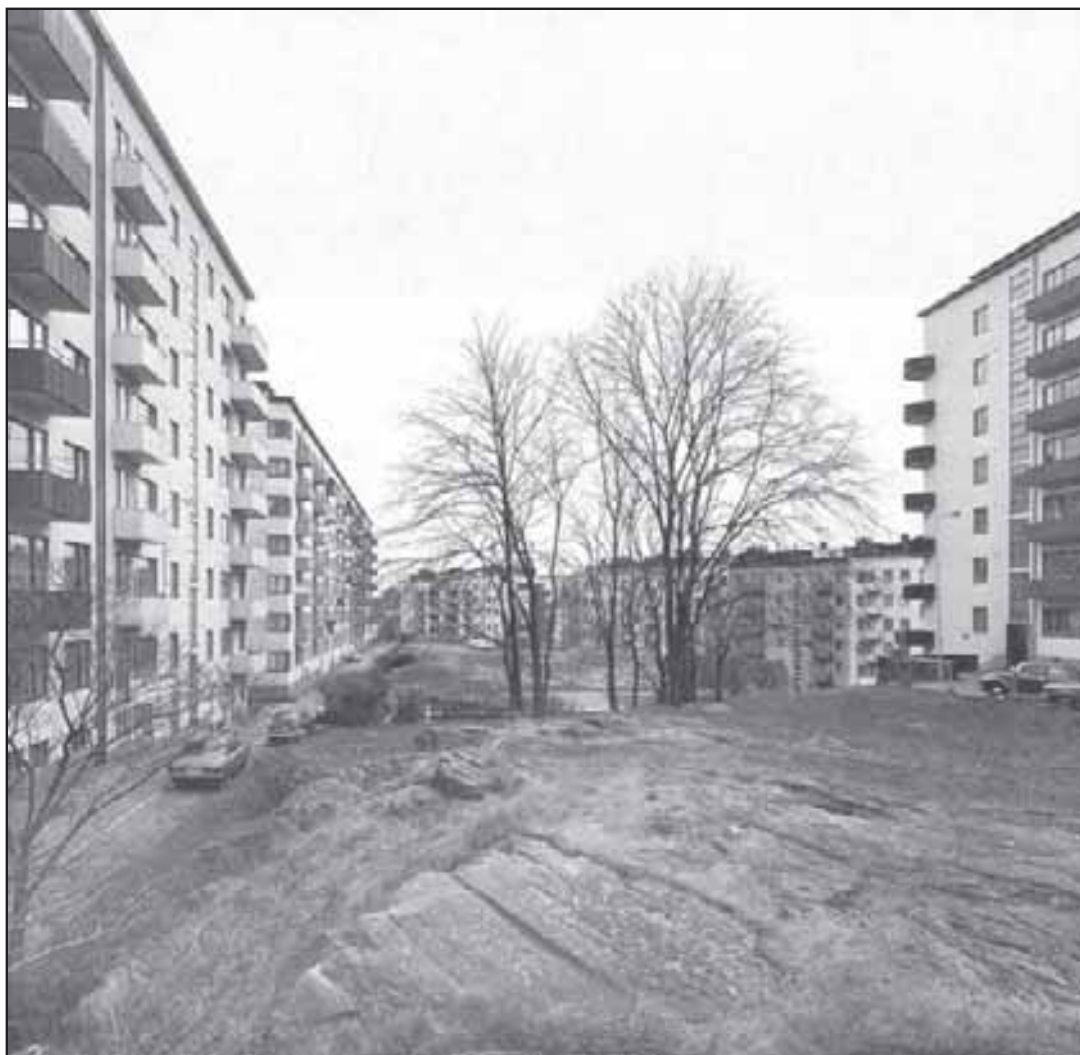
Bild 63. Mellan väderstrecksoorienterade långa huskropppar råder öppenhet och kvarlämnade rester av traktens en gång vilda, otuktade natur - en för sin tid revolutionerande stadsbyggnadskonst.
