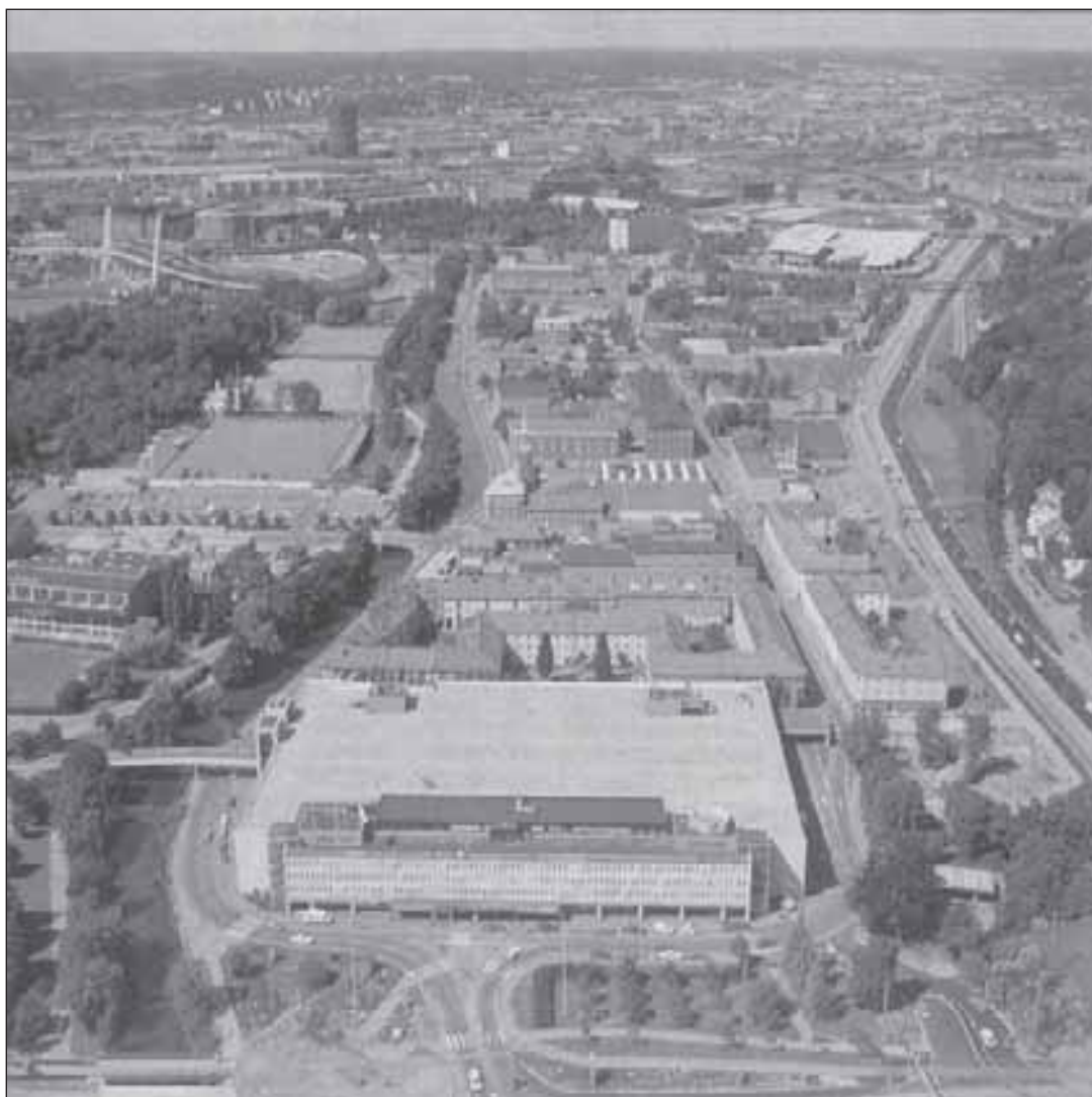
Bild 130. På östra sidan av Mölndalsån, som före 1922 utgjorde gräns mellan Örgryte och Göteborg, anlades i slutet av 1800-talet en rad fabriker som gav upphov till Gårda municipalsamhälle. Flera kvarter med industribyggnader och bostäder har bevarats.
