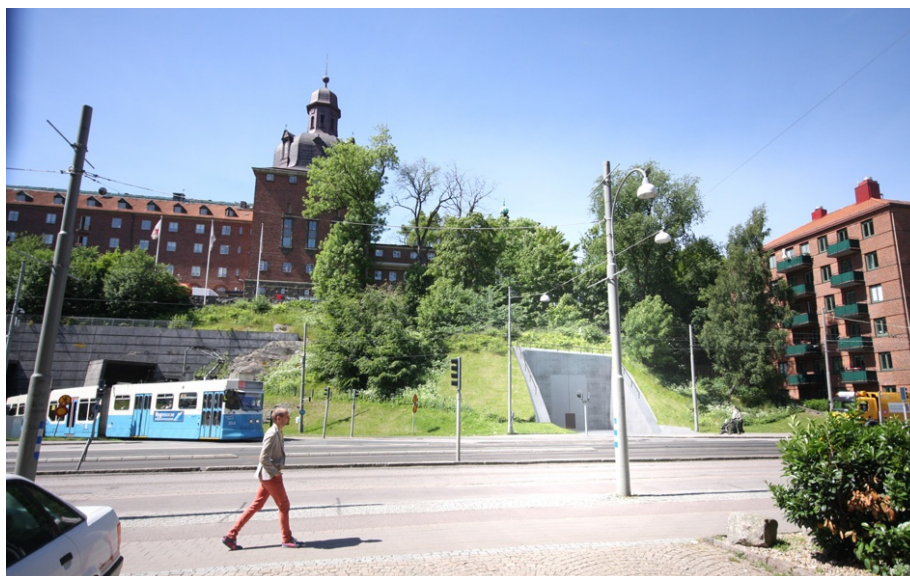
Servicetunnel- mynning vid Carlanderska
