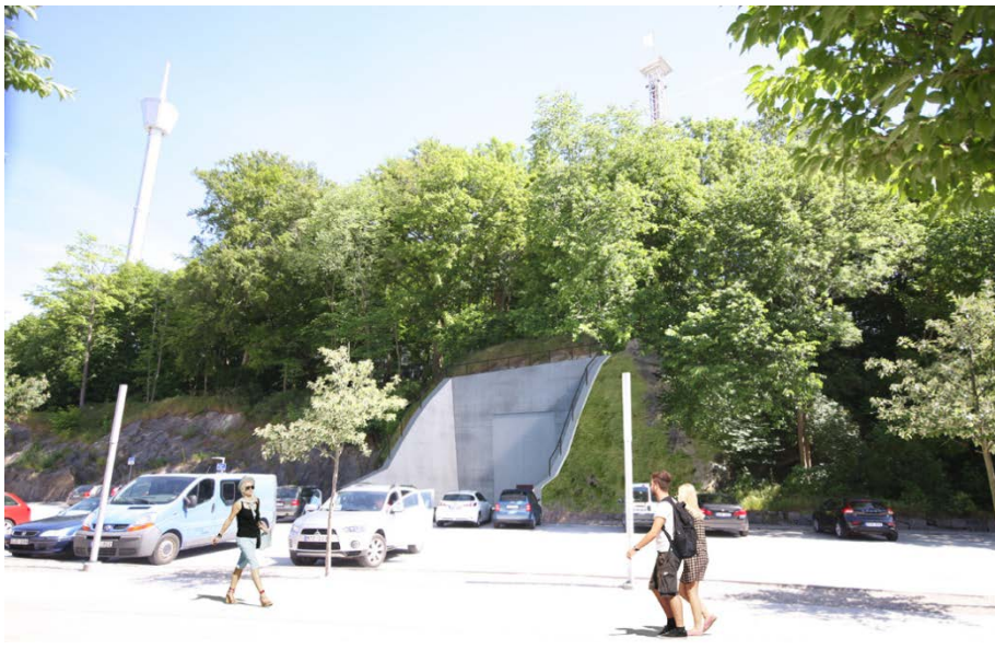
Service-tunnelmynning vid Liseberg
