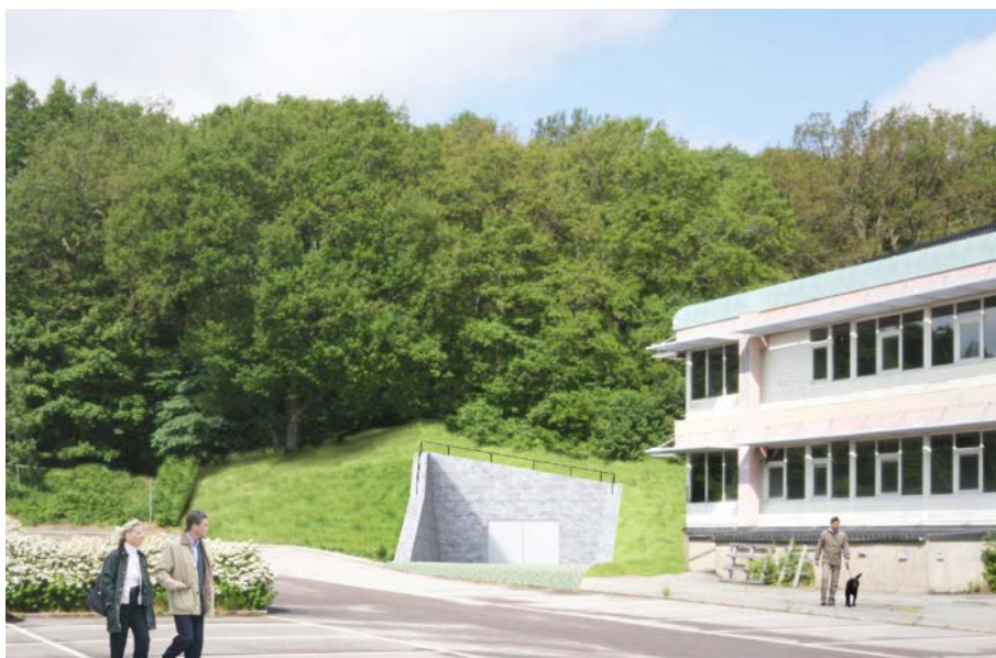
Service-tunnelmynning vid Sankt Sigfridsgatan
