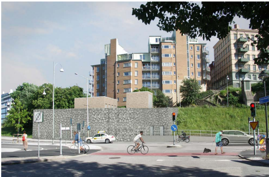
Serviceschakt Sankt Eriksgatan sett från Göteborgsoperan
