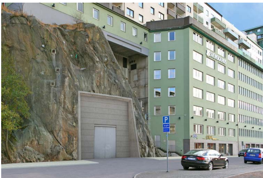
Servicetunnelmynning Stora Badhusgatan
