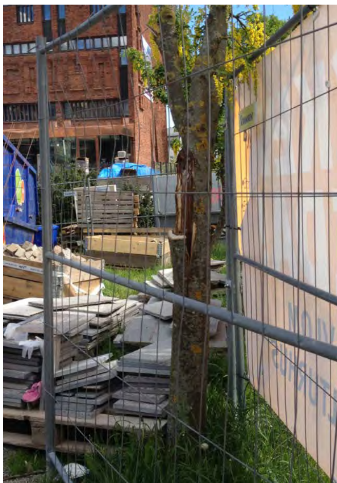
Figur 16. Inträngt och skadat träd bland byggmaterial och utan skydd. Med tydliga åtgärder för träd i handlingar, en genomtänkt upphandling och en trädcentral ska träd inte behöva hanteras på detta sätt under byggnationen. Foto: Maria Thorell, 2013.
