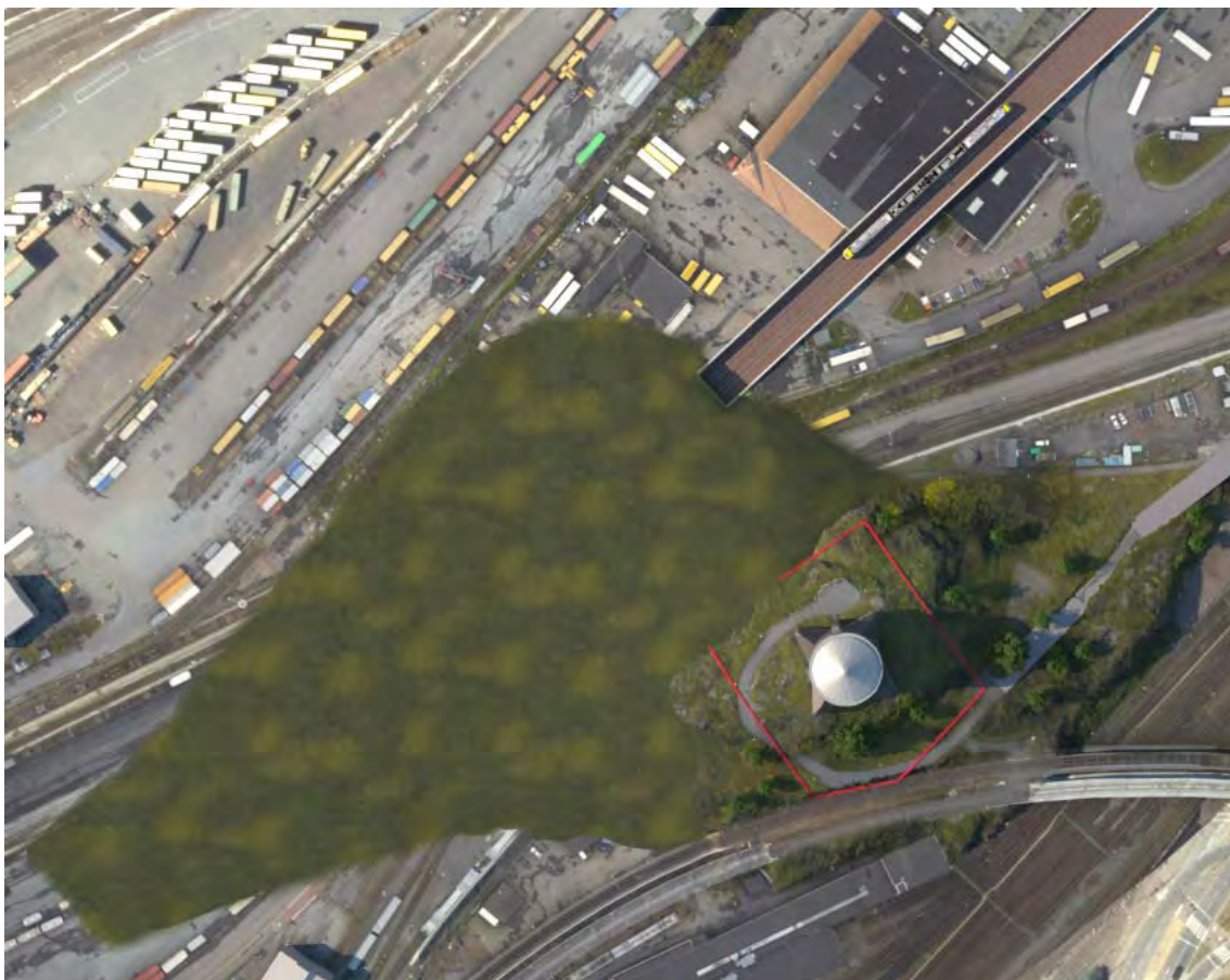
Figur 3. Västlänken planeras att gå på bro över E6, därefter i tråg som övergår i tunnel genom Skansen Lejonet (Stadbyggnadskontoret, Göteborgs Stad 2013). Illustration: Göteborgs Stadsbyggnadskontor.
