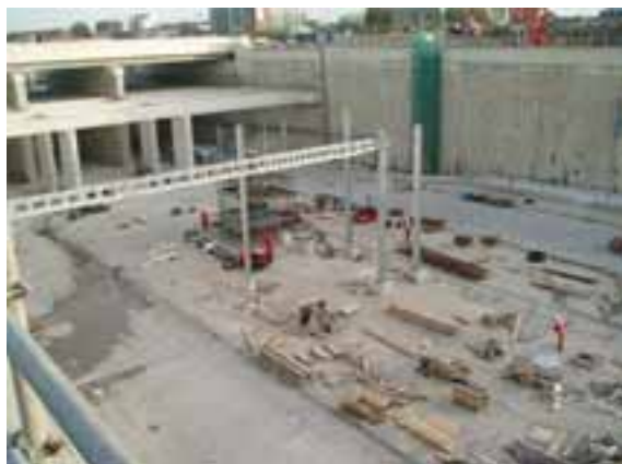
Fyrspårsstation i betong med väggar av slitsmurar under byggnad i London.
