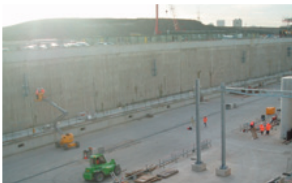
Schakt med slitsmurar i London.
