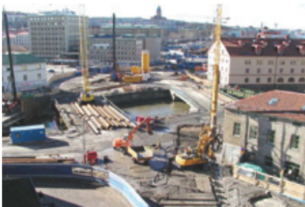
Sponningsarbeten för Götatunneln vid Järntorget.
