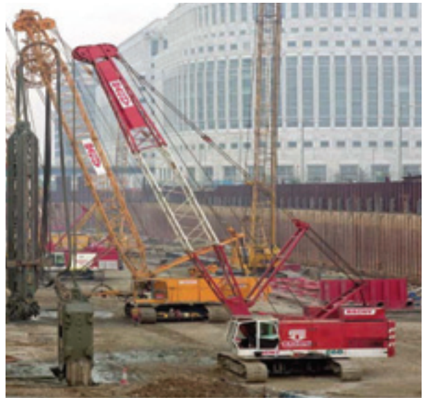
Slitsmursarbeten för tunnelbansstationen vid Canary Wharf i Dockland, London.
