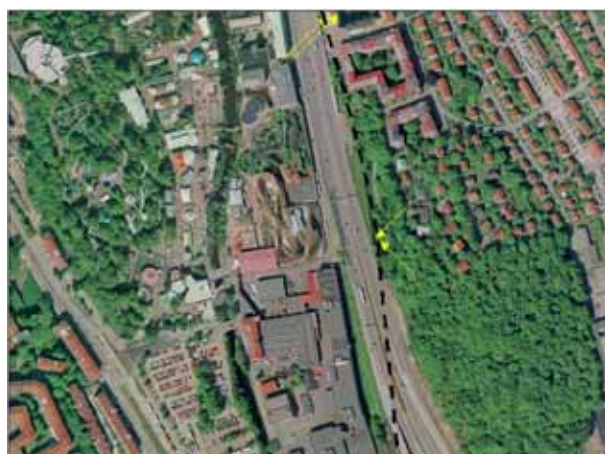
Figur 4.7 Bilden visar tunnelns södra del och två mätpunkter i Hemtjänsts lokaler på Påskbergsgatan (fastighet 33:10) samt två mätpunkter nästan rakt ovanför tunneln med enstaka meter bergtäckning - invid gångvägen strax öster om Nellickevägen (fastighet 750:759).
